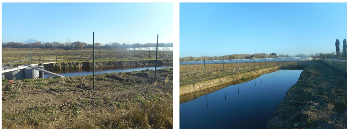
Figure 17 Bassin de rétention sur le site d'étude
