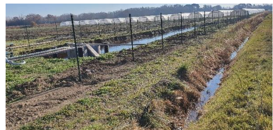
Bassin de rétention
