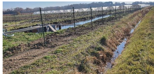
Bassin de rétention
