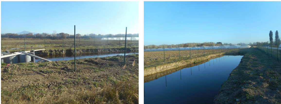
Bassin de rétention sur le secteur d'étude
