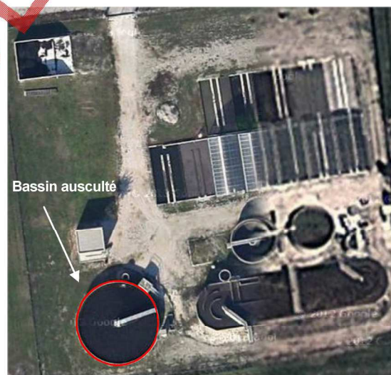
Fig. 1 : Aperçu général de la STEP de Sarrians- vue aérienne
